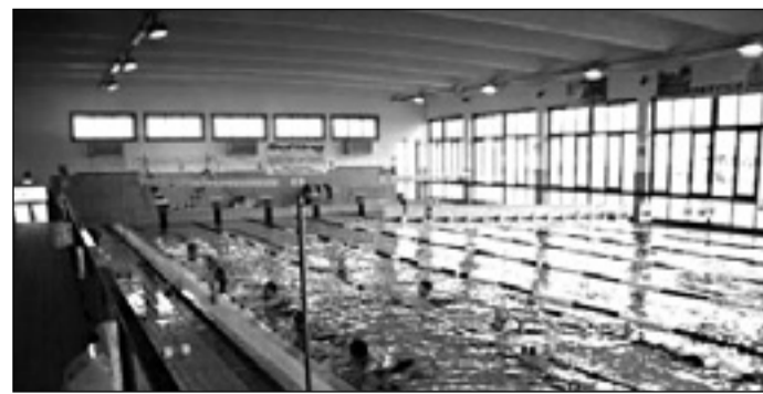
Una delle vasche dell'impianto in via Melato
